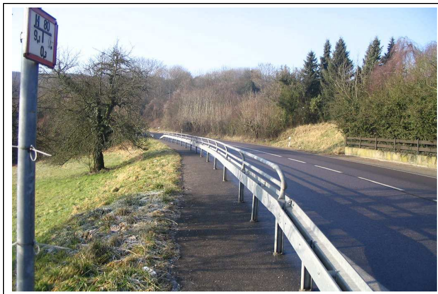
Bild 6-15: Gemeinsamer Geh- und Radweg mit zu geringer Breite; fehlende Ausweichmöglichkeit, fehlende Absturzsicherung (B 269, Überherrn)
