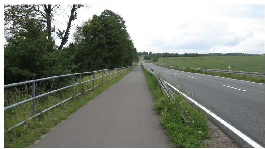
Bild 6-6: Gemeinsamer Geh- und Radweg für Zweirichtungsradverkehr. Rückhaltesystem zwischen Fahrbahn und Radweg und Absturzsicherung (B 420, Ottweiler)
