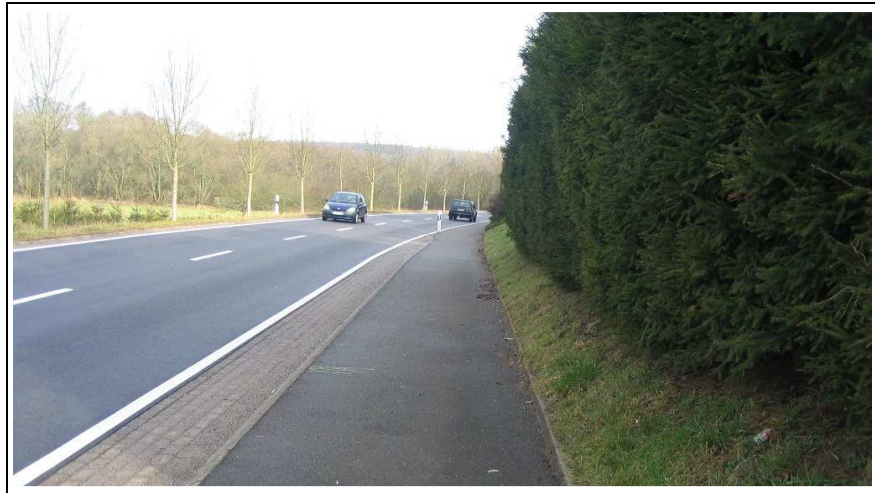
Bild 6-5: Gemeinsamer Geh- und Radweg für Zweirichtungsradverkehr mit befestigtem Sicherheitstrennstreifen (L 105, Blieskastel)
