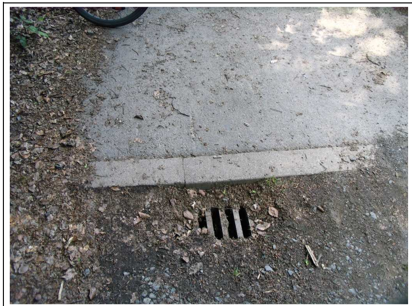
Bild 5-18: Punktueller Mangel: Gully mit Einlaufrinnen in Fahrtrichtung (Sulzbach)
