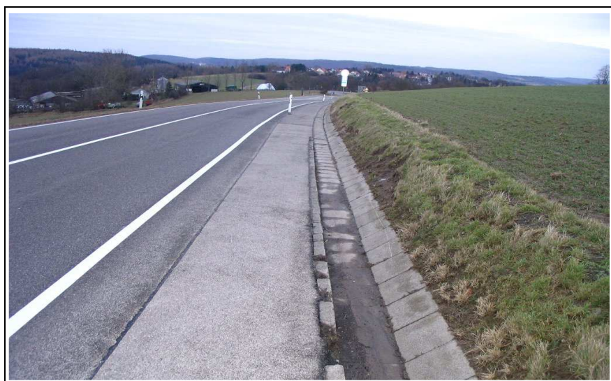
Bild 6-7: Gemeinsamer Geh- und Radweg auf abmarkiertem Seitenstreifen; Sturzgefahr durch Rinne (L 107, Blieskastel/Biesingen)
