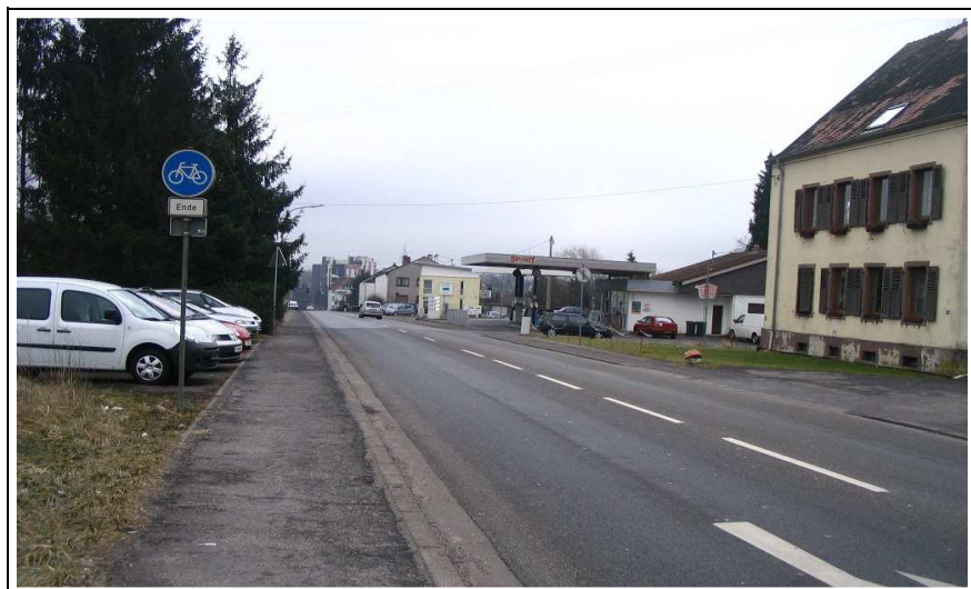
Bild 6-20: Ungesicherte Querung am Ende eines Zweirichtungsradweges (B 51, Kleinblittersdorf)
