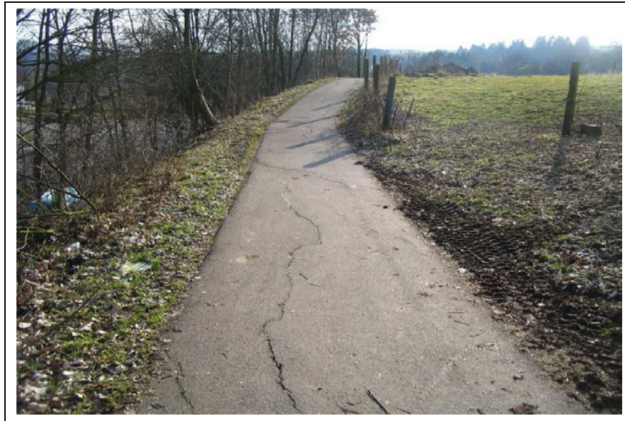
Bild 6-16: Gemeinsamer Geh- und Radweg mit Belagsschäden (B 269, Lebach/Aschbach)
