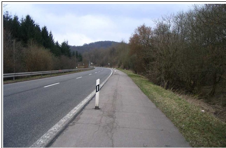
Bild 6-33: Durch Leitpfosten abgetrennte Radverkehrsführung auf früherem Mehrzweckstreifen (L 147, Nonnweiler)
