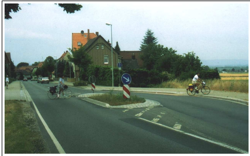
Bild 6-27: Mittelinsel als Querungshilfe in einer Ortseinfahrt
