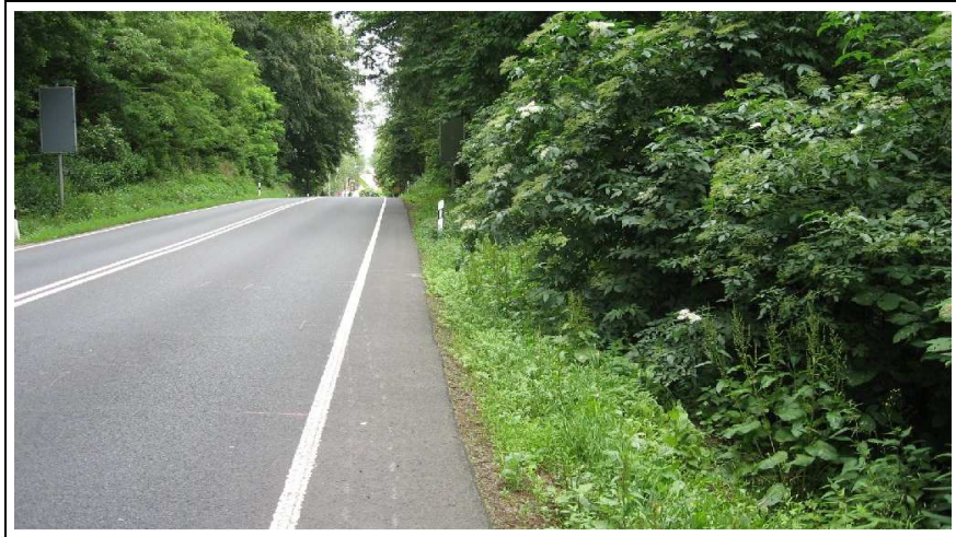
Bild 6-8: Befestigter Seitenstreifen ohne Radverkehrsführung (B 269, Marpingen)
