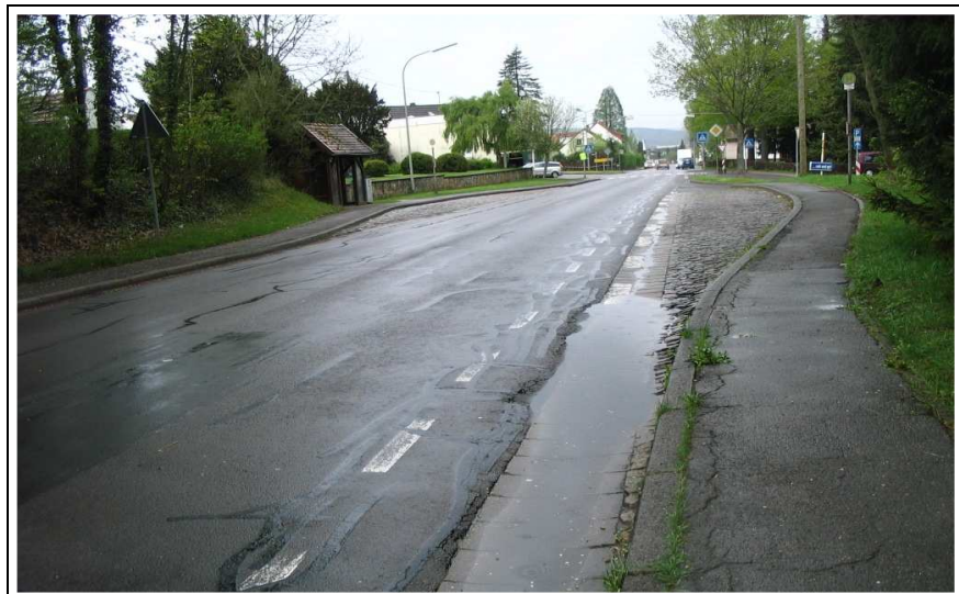
Bild 6-19: Zu schmaler Schutzstreifen mit schlecht nutzbarer Rinne (L 173, Merzig/Hilbringen)
