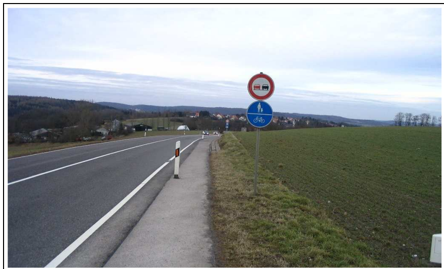
Bild 6-17: Zu schmaler gemeinsamer Geh- und Radweg; Sturzgefahr beim Ausweichen durch Asphaltwulst (L 107, Blieskastel)
